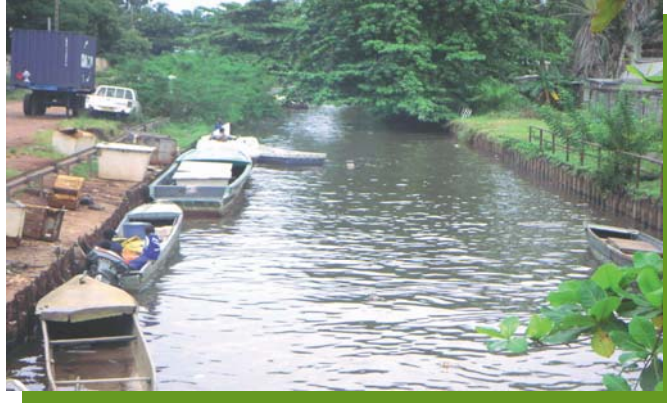
Photo 4 : Le réseau de canalisation vieillissant et mal entretenu à Port-Gentil
