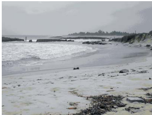
Photo 2 : Brise lames mal positionnés près du canyon du Cap Lopez
